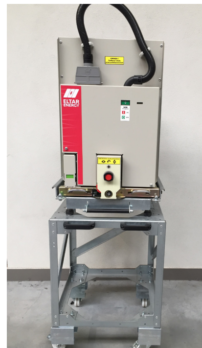
Fot nr 3: Człon wysuwny rozdzielnicy MILE z napędem magnetycznym na wózku serwisowym.
